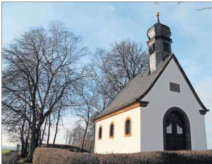
Die Außenfassade der Kriegergedächtniskapelle in Reifenberg konnte mit Hilfe der Daniel Theysohn Stiftung komplett saniert werden. (Foto: Hagen)
