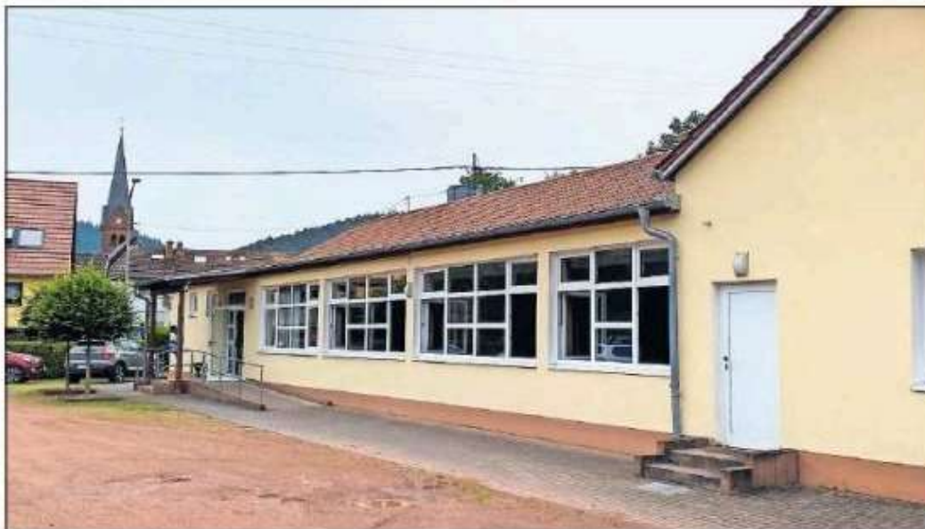
Die Gemeindehalle in Bobenthal soll saniert werden. In einem ersten Bauabschnitt sollen die Barrierefreiheit hergestellt und die Halle klimaschutztechnisch ertüchtigt werden.
